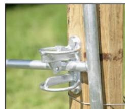
Montageversatz der Scharniere kann durch Verstellen der Gewinde-Scharnierbolzen ausgeglichen werden!
